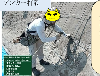
アンカー打設
